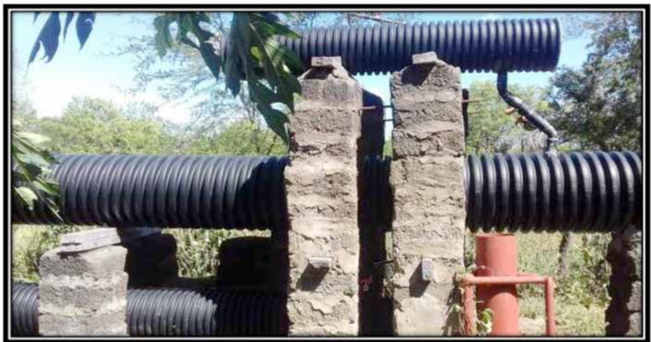
Fotografía del biodigestor que produce la energía calorífica a partir del gas que se produce del estiércol de ganado bovino.
